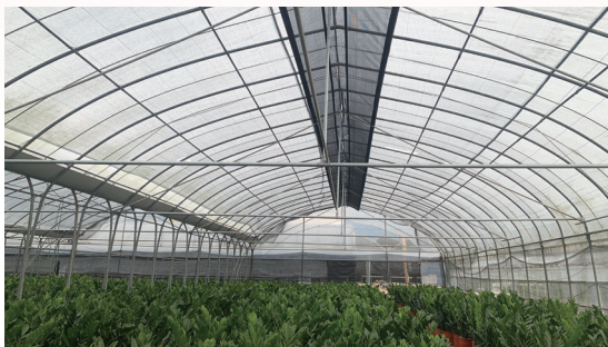
圖 6. 埔里產區自動化三角內遮陰網
