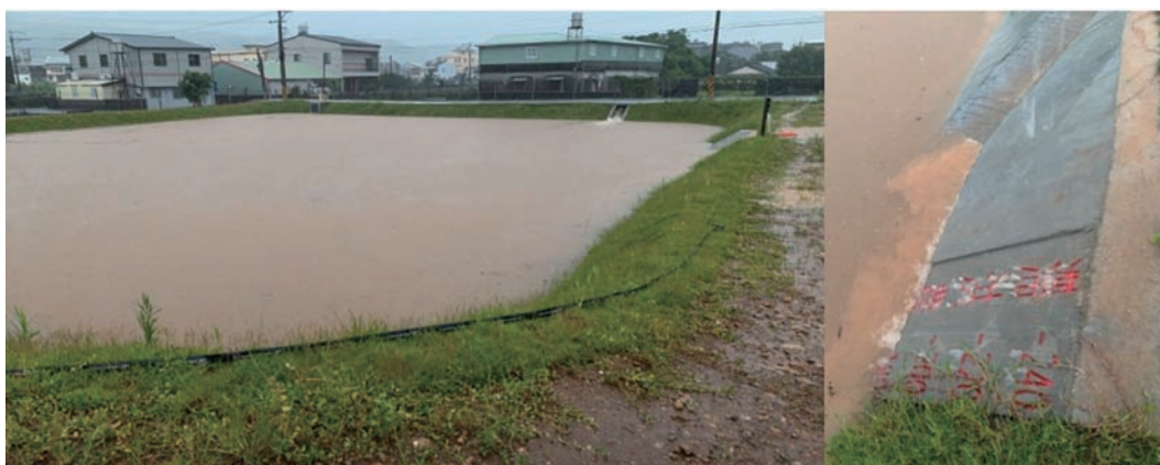
圖 9-5、滯洪農塘之實際滯洪情形
