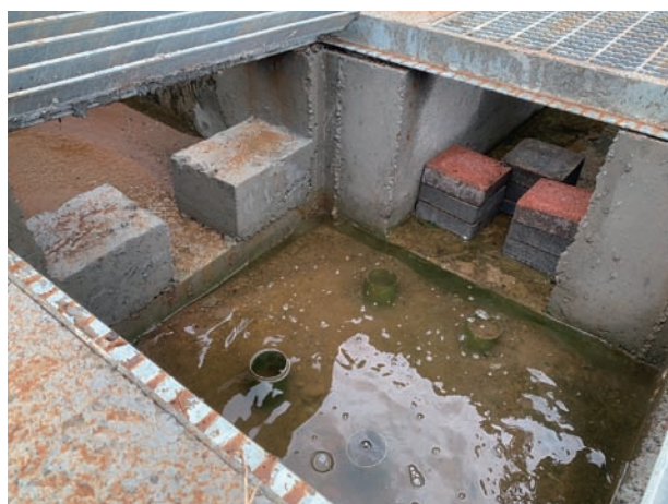
圖 9-6、水流臨時性調節設置情形
