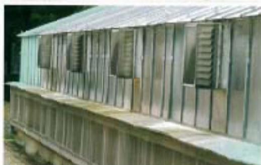
圖3. 法國國家農業技術研究院 (Institut national de la recherche agronomique, INRA) 基因轉殖植物隔離溫室的進氣風扇外部包覆有防蟲網。
