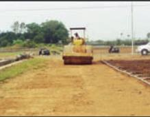
使用大型機具壓實步道，整平路面
